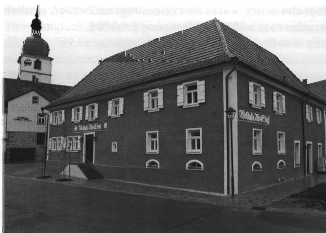
Sugenheim, Lkr. Neustadt a. d. Aisch-Bad Windsheim; ehem. Gasthof Stern, Südostecke 2008 (Foto: Büro Liebbecker & Schwarz)
