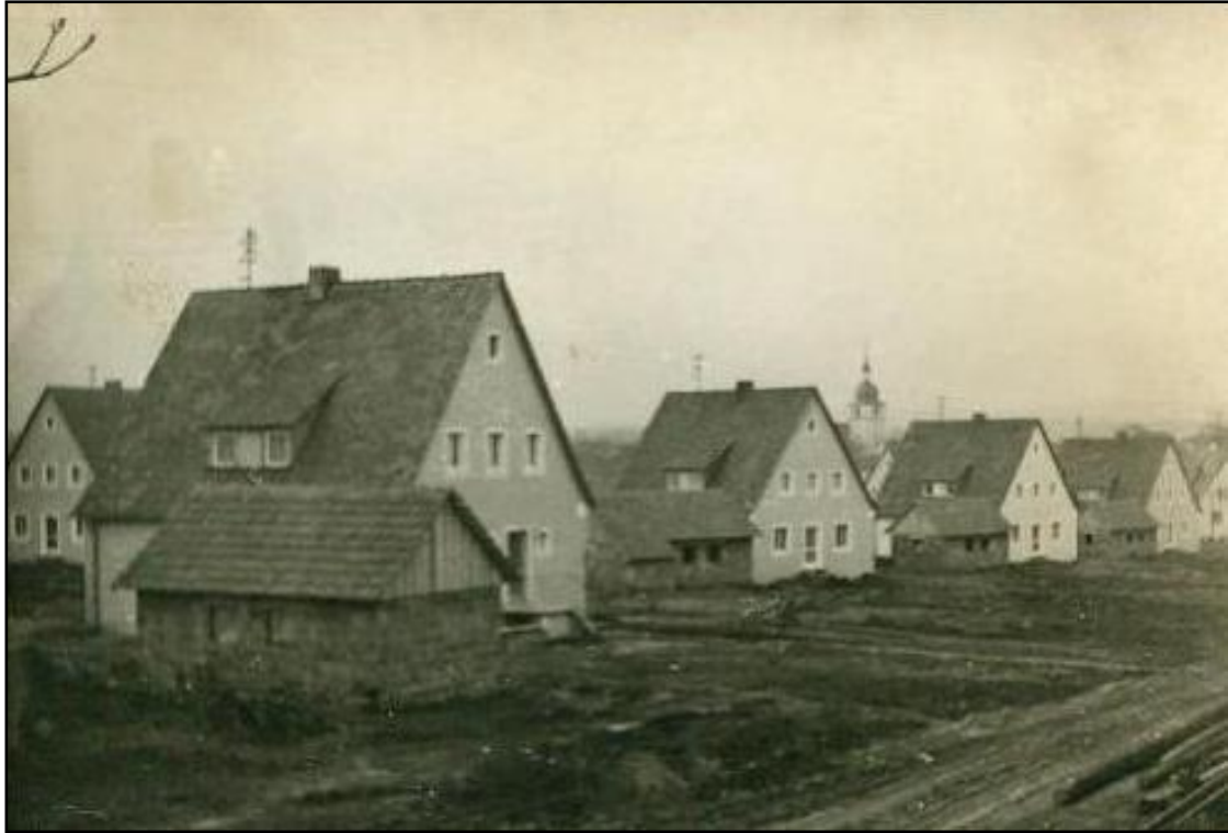
Der erste Bauabschnitt der Bayerischen Landessiedlung im Jahre 1960 steht. Der Straßenausbau fehlt noch. Foto: Besitz Leo Pecher
