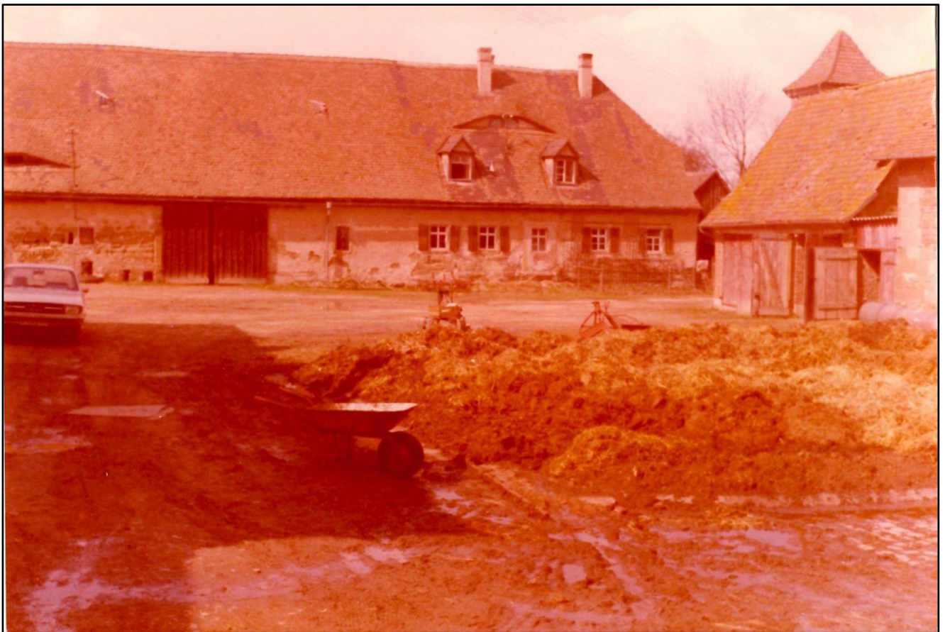
Querbau links Scheune für Getreide und Maschinen, rechts Wohnungen für die Gutshofbeschäftigte. Rechts Garagen und Trafo-Haus. Foto Andrea Chaves
