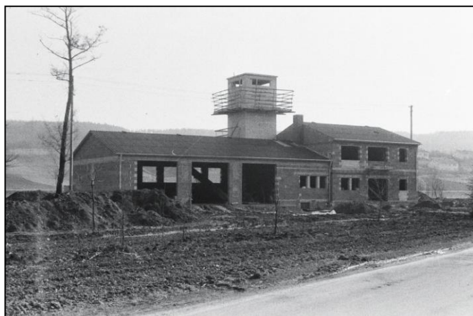
Das Feuerwehrhaus 1974 im Rohbau
